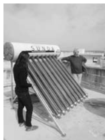
太陽熱を利用し水を温水に変えるシステム
